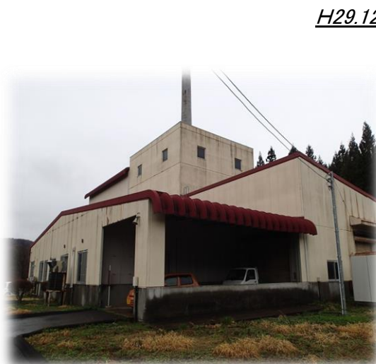
藤里町において解体撤去が行われる 旧二ツ井藤里地区行政組合清掃センター
