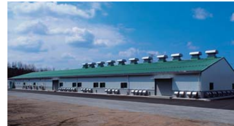
◆風の松原風力発電所の蓄電池施設
