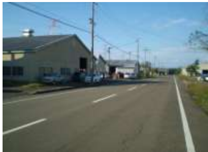
未利用地がある木材工業団地
