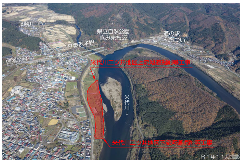
図2 ニツ井地区河道掘削事業
